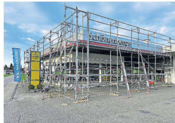
Die gesamte Gebäudehülle wurde aufgefächert und auf den neusten Stand gebracht.
