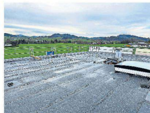
Das Dach wurde erneuert.
