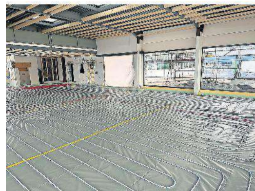
Die Bodenheizung wurde komplett neu realisiert.
